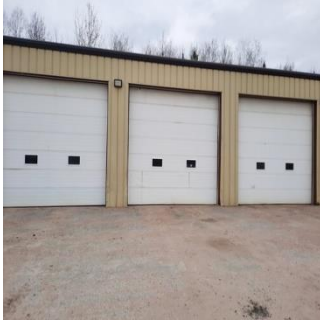
Front Bay Doors (5) Nos.
